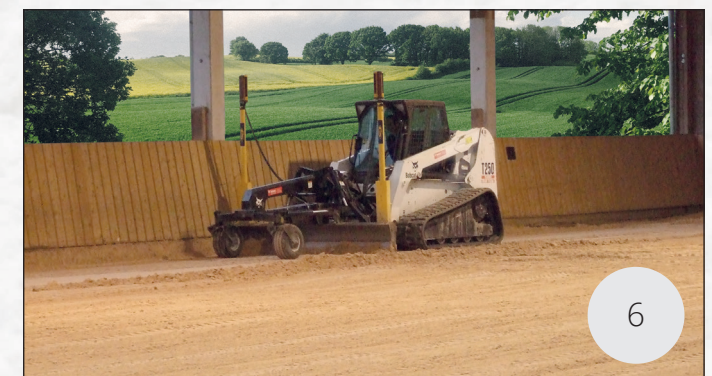
Egalisieren der Tretschicht
