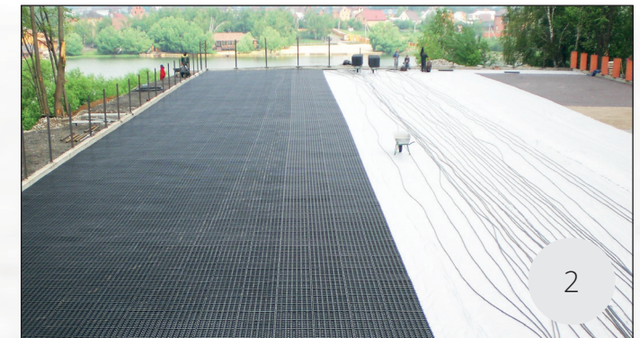
Verlegen der HIT-Bodenraster und Tropfrohre
