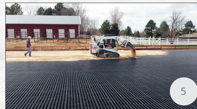
Verfüllung HIT Bodenraster
