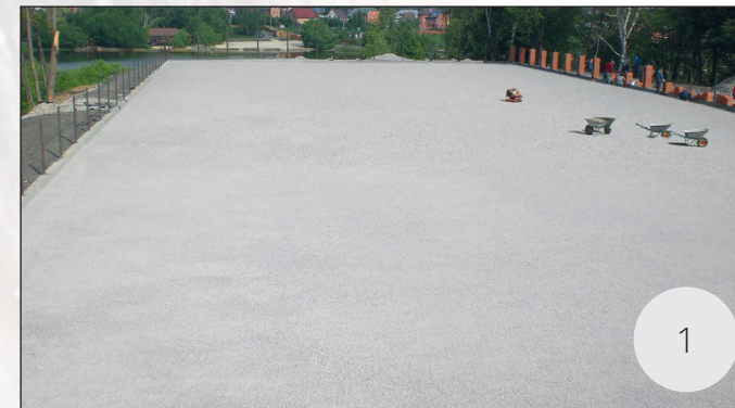
Aufbringen der Tragschicht
